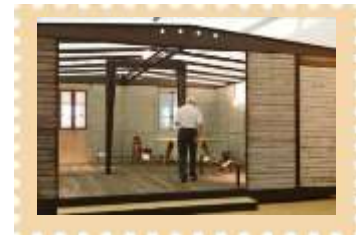
La maison des sinistrés (1944), des ateliers Jean Prouvé avec son système constructif à portique axial.
